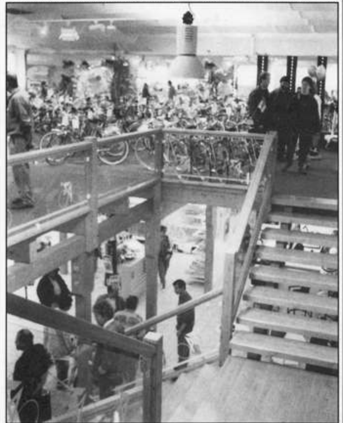
Über diesen komplett aus Leimholz gebauten Treppenaufgang gelangt man in die Verkaufsausstellung. Die gesamte Etage ruht auf einer in die ehemalige Speditionshalle eingebauten Leimbinderkonstruktion. Nicht nur die Idee für diesen gelungenen Innenausbau stammt vom Familienrat, auch ein großer Teil der Umgestaltungs- und Renovierungsarbeiten wurde in Eigenleistung erbracht.
